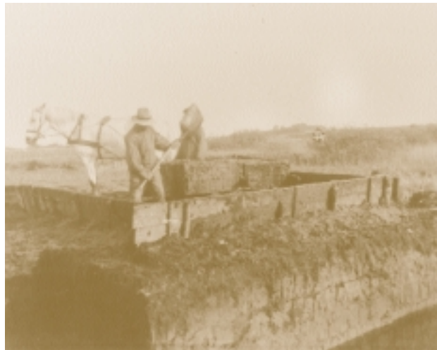
Æltkassen er opstillet på kanten af tørvegraven. Efter æltningskovles tørvemassen op i en tørvesluffe - en hestetrukken slæde, der transporterer tørven til tørrepladsen. Tysmosen 1907.
