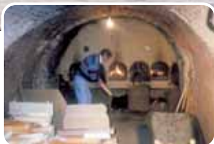
I de lavloftede ovne blev de håndstrøgne sten stablet og brændt.
