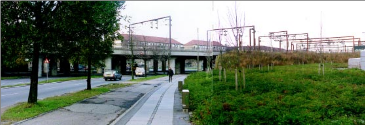
Ved Sydhavn Station føres cykelruten under baneliniernes broanlæg og fortsætter på nordsiden ad sydhavnsstien.
