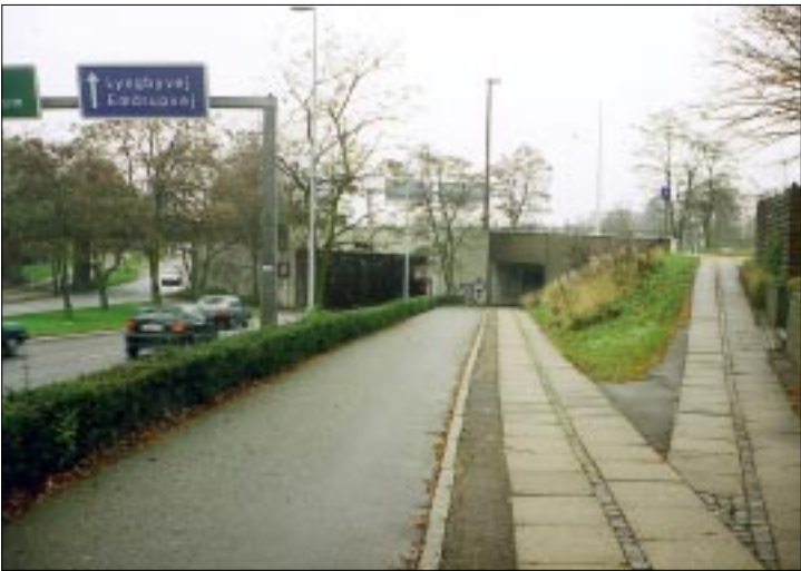
Passagen over Lyngbyvejens motorvejsanlæg foregår på de eksisterende bro- og stianlæg.
