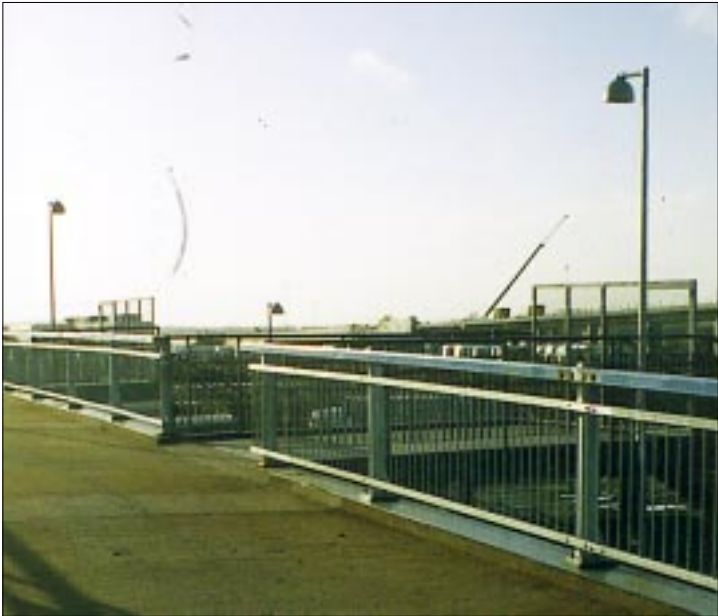
Cykelruten passerer jernbane og motorvej på eksisterende nyanlagt stibro.
