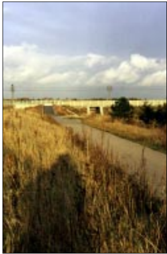
Kalvebodruten har god forbindelse ved Øresundsbanen i nord til Lufthavnslinjen og Kastrup Fort ruten.
