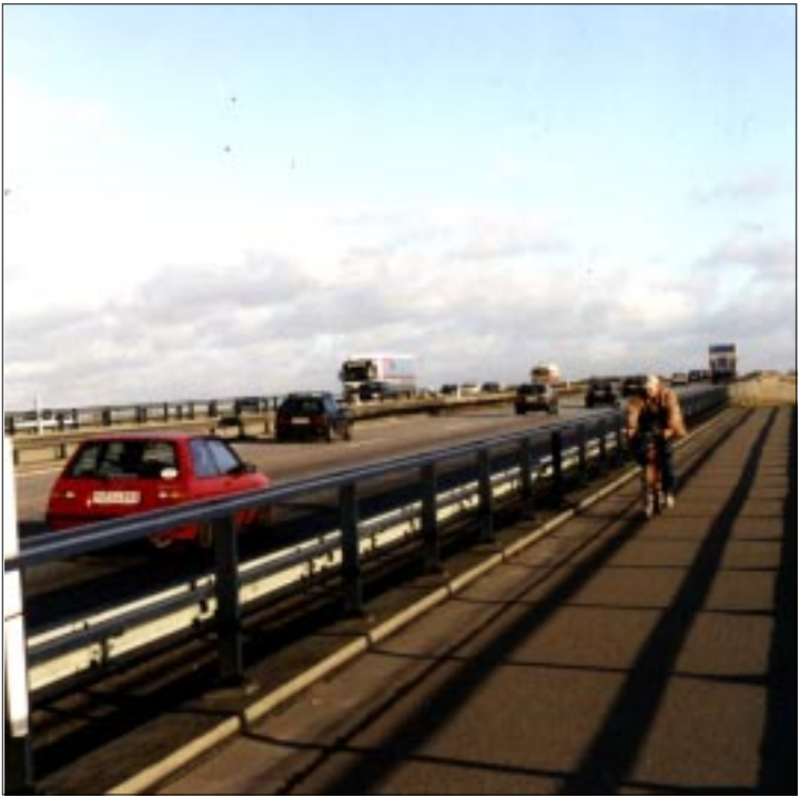
På Skrædderholmen ligger motorvej og stiføring sammen på Kalvebodbroen godt 30 m over havet.
