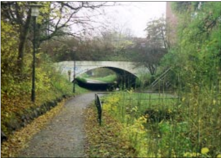
Cykelruten ligger i en viadukt under Frederiksborgvej ved Dunhammervej.
