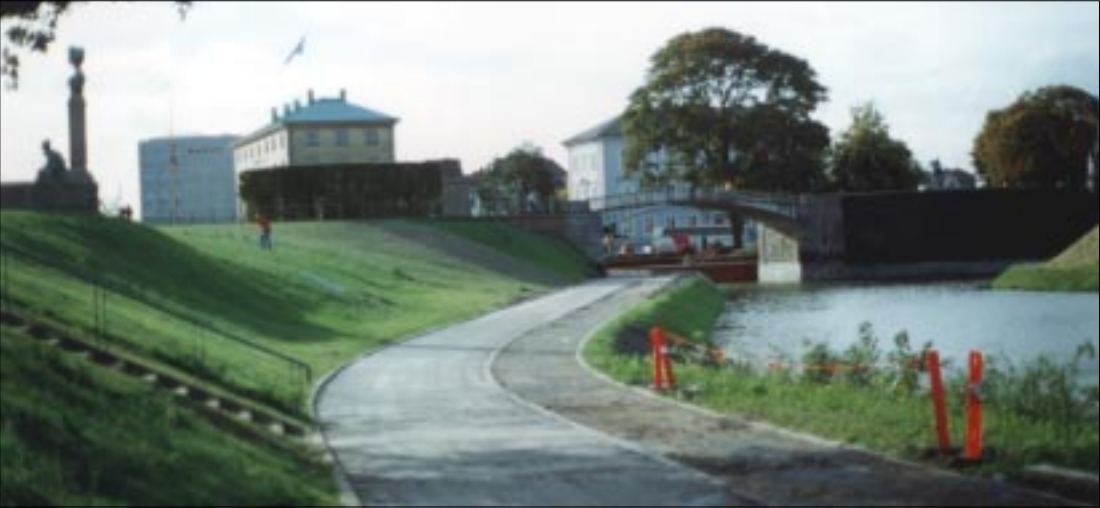
Ved Kastellet forløber ruten ad den nyligt anlagte cykel- og gangsti.
